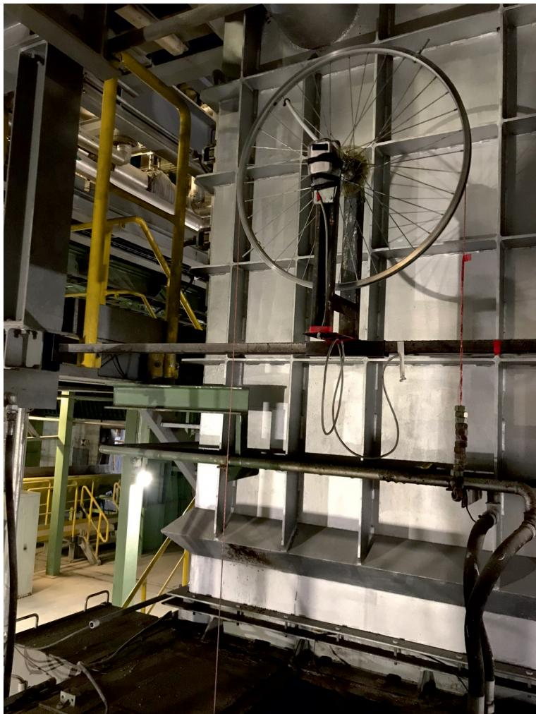
Kreativní oprava špatně fungujícího odtoku odpadní vody v jedné z českých spaloven odpadu. Zaměstnanci pomocí ráfku starého kola, plováku, lanka a matic vytvořili zařízení, které lépe reguluje odtok. Důvodem byl původně nedomyšlený design odtokového potrubí.
